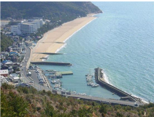
渋川海岸 (第1休憩所手前より)
